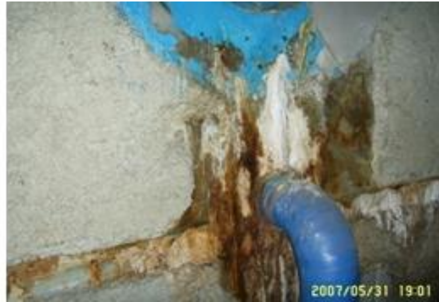
수조 벽 바닥 데크 : 타일 박리 및 미장 부분 들뜸 현상, 스테인레스 도색 탈락
