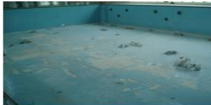
수조 벽 바닥 데크 : 타일 박리 및 미장 부분 들뜸 현상, 스테인레스 도색 탈락
