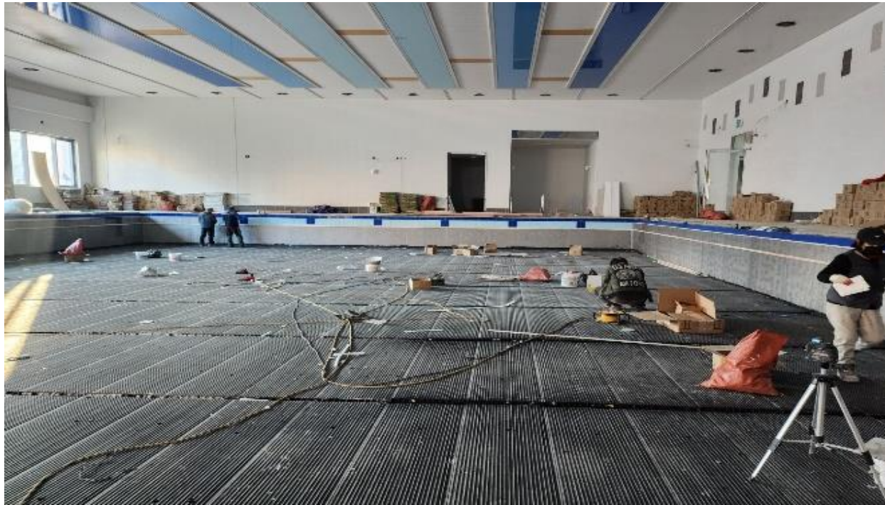
수조 바닥 1차 방수 (자착식) 작업
