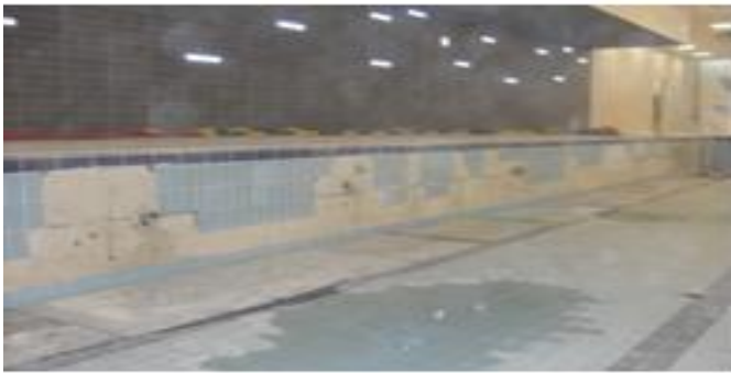
수조 벽 바닥 데크 : 타일 박리 및 미장 부분 들뜸 현상, 스테인레스 도색 탈락
