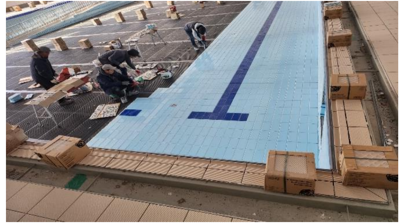
수조 줄눈 일체형 합성수지 타일 바닥 작업
